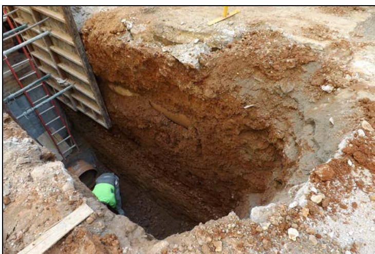
Vista del perfil del Tram 11
