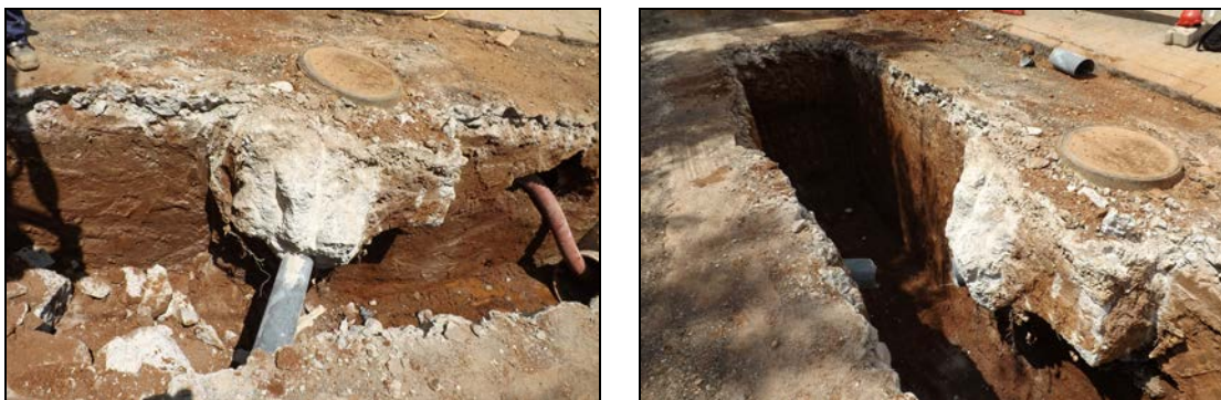
Vista del pou de registre i la canalització UE 146
