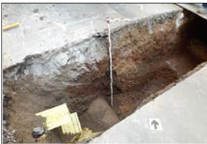
Vista de l'inici de l'excavació de la Cala 2. La cala on cop finalitzada i imatge del perfil
