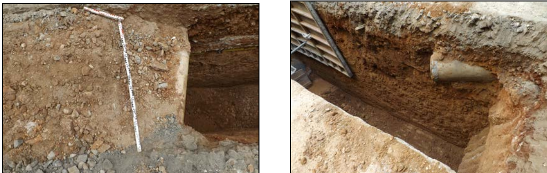
Detall de l'escomesa UE 130 i UE 131 a la dreta ja desmuntada
